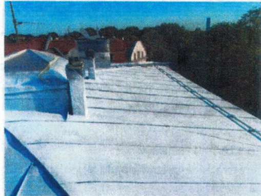
Bild 3 und 4 Auftragung der ersten Schicht ADITIZOL BASIC
