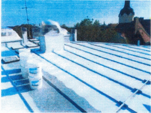
Bild 3 und 4 Auftragung der ersten Schicht ADITIZOL BASIC
